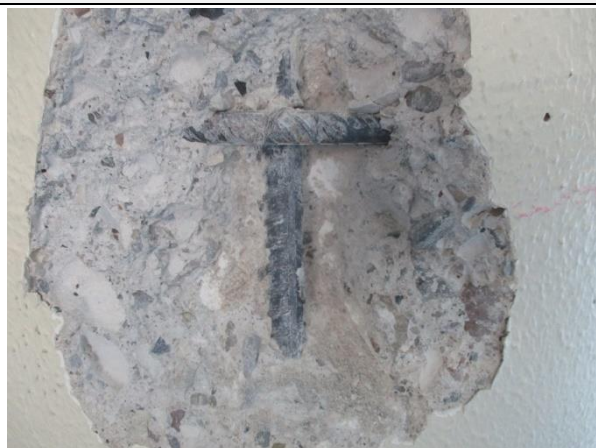
Particolare dell'armatura rilevata
