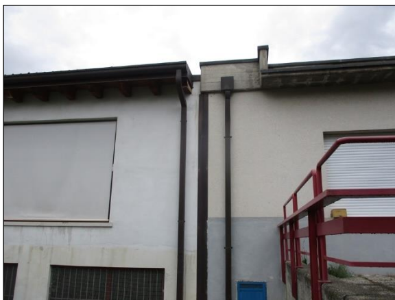
Foto n°2 - Osservazione generale delle due US accostate senza l'interposizione di giunti sismicamente efficaci
