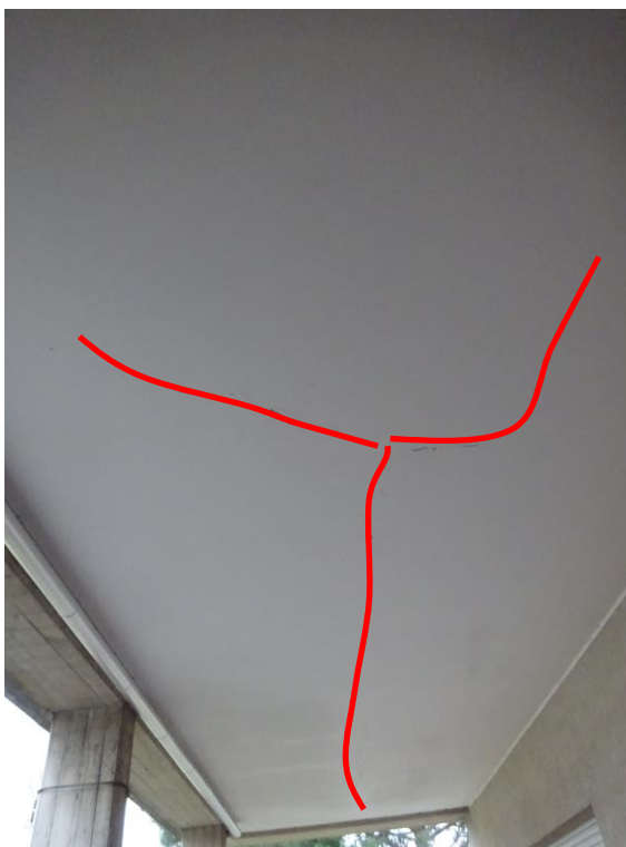
Figura 60 - Fessura solaio tettoia d'ingresso.
