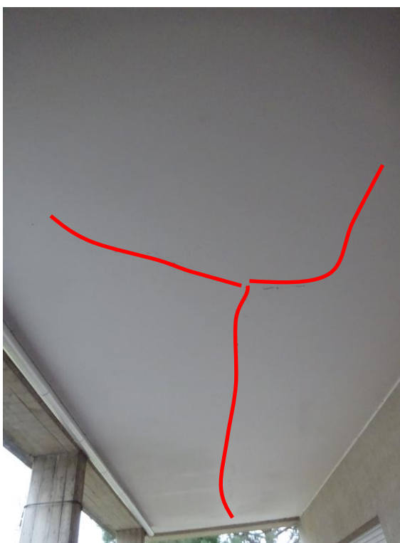
Figura 7 - Fessura solaio tettoia d'ingresso.
