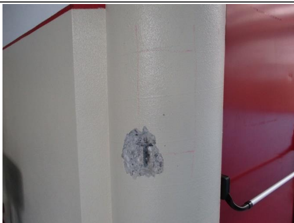
Osservazione generale della scarifica effettuata sul Pilastro C032
