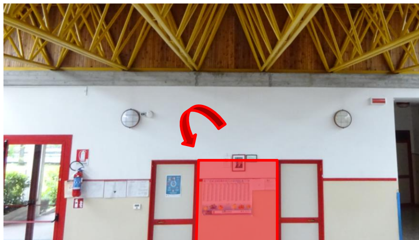
Figura 21 - Meccanismo ribaltamento Maschio su atrio (Corpo B).
