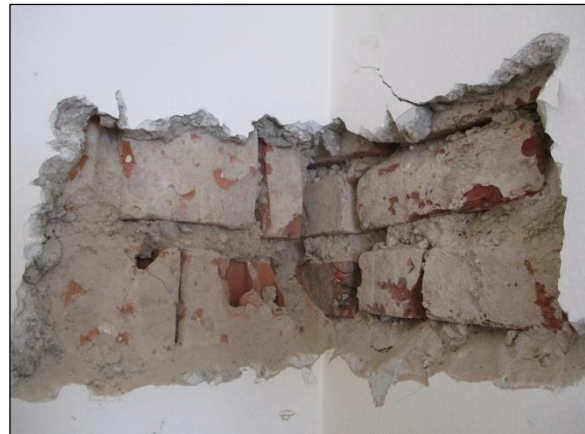
Foto n°5 - Scarso ammassamento rilevato tra le differenti tipologie di setti murari dell'Unità Strutturale
