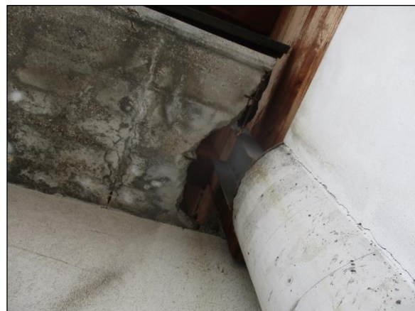
Foto n°3 - Particolare dell'accostamento tra le Unità Strutturali US1 ed US2
